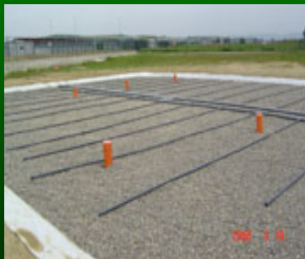
2_POSA IN OPERA DEI TUBI DI SUPERFICIE
